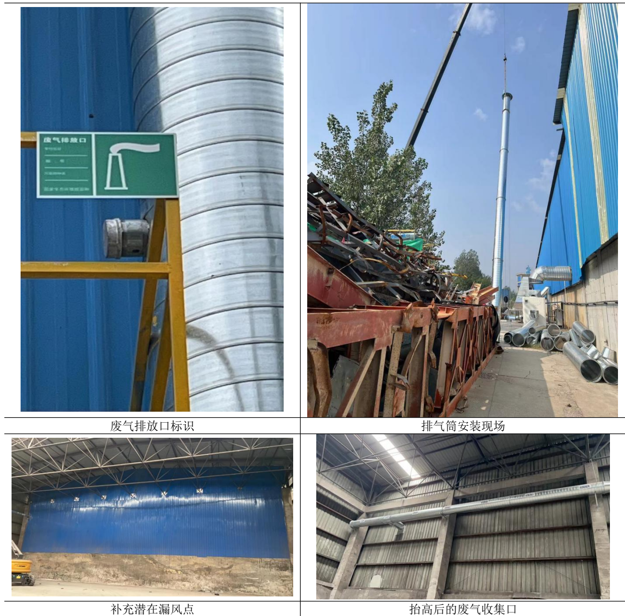
图 4.1-1 废气处理设施图
