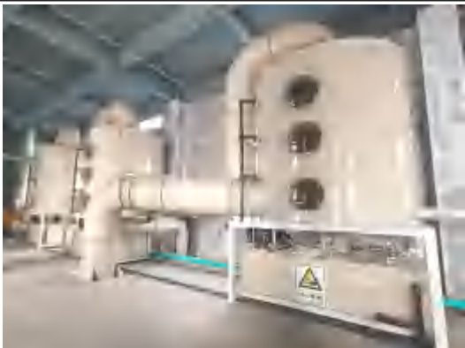
酸性废气处理装置-三级处理装置
