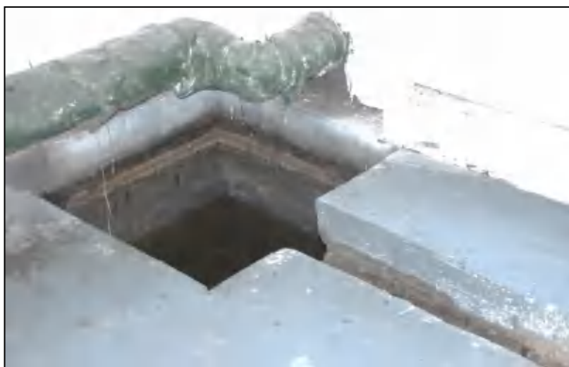
图 4.2-1 催化剂车间导流槽和导流沟
