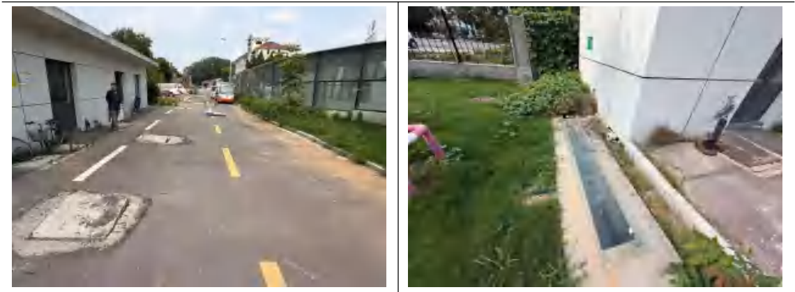
图 4.2-2 污水处理站现场照片
