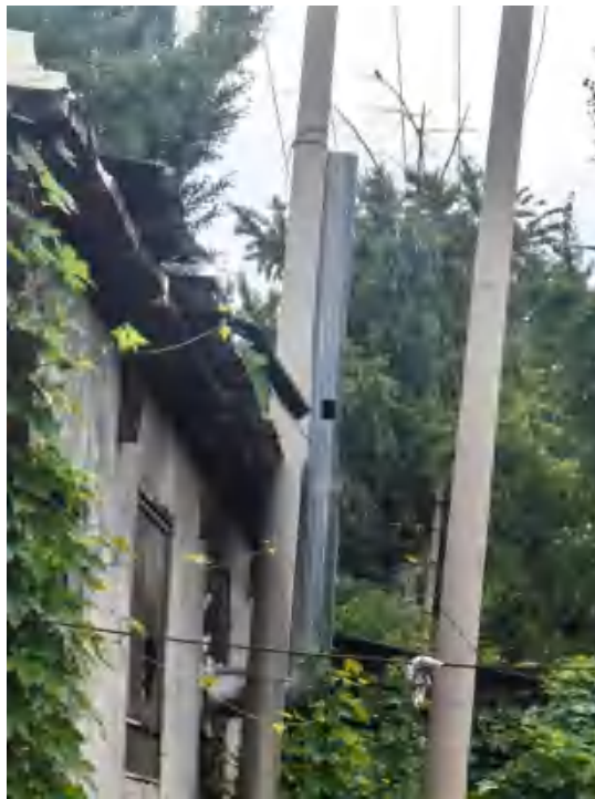
图 4.1-1 食堂废气处理设施图
